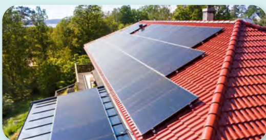
รูปที่ 3.2 Source: แสดงลักษณะ Solar rooftop
